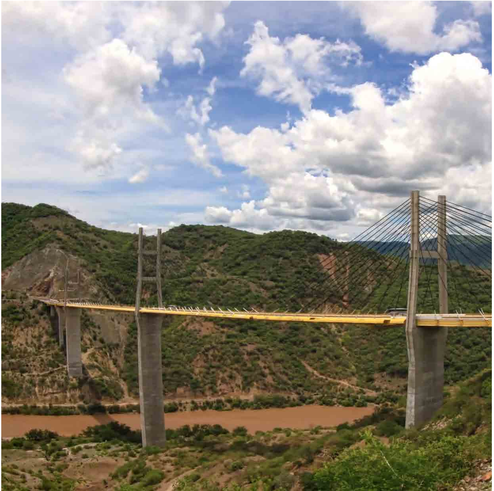
AUTOPISTA DEL SOL PUENTE DE IXTLA
