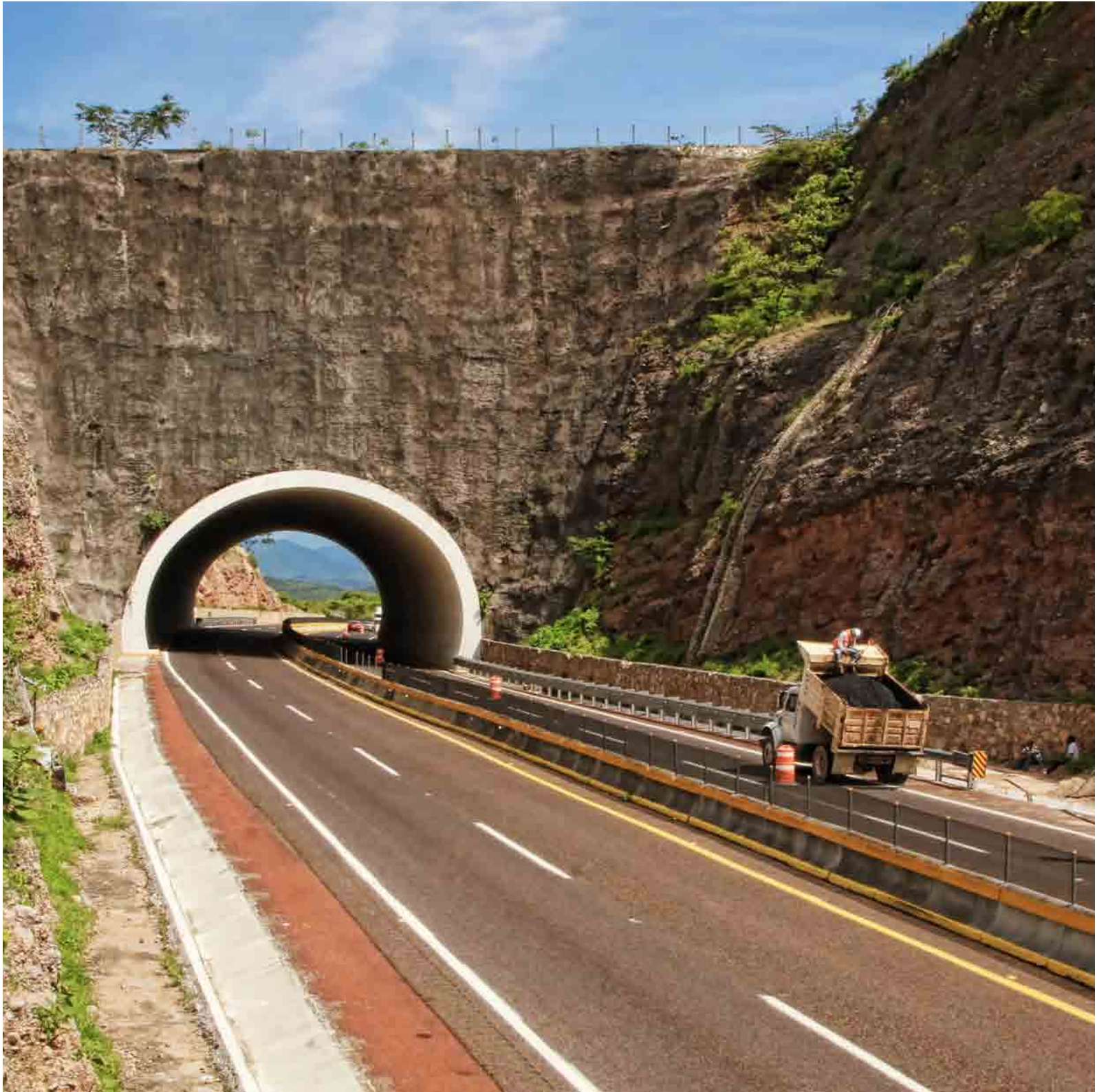
AUTOPISTA DEL SOL TÚNEL DE BAJO DE LAS RUINAS CUETLAHUCHITLAN
